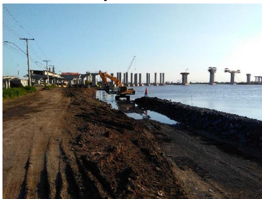
Enrocamento da Rua João Moreira Maciel
