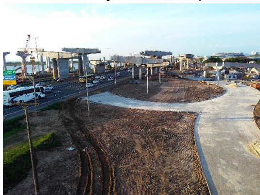
Pavimentação da Avenida Voluntários da Pátria
